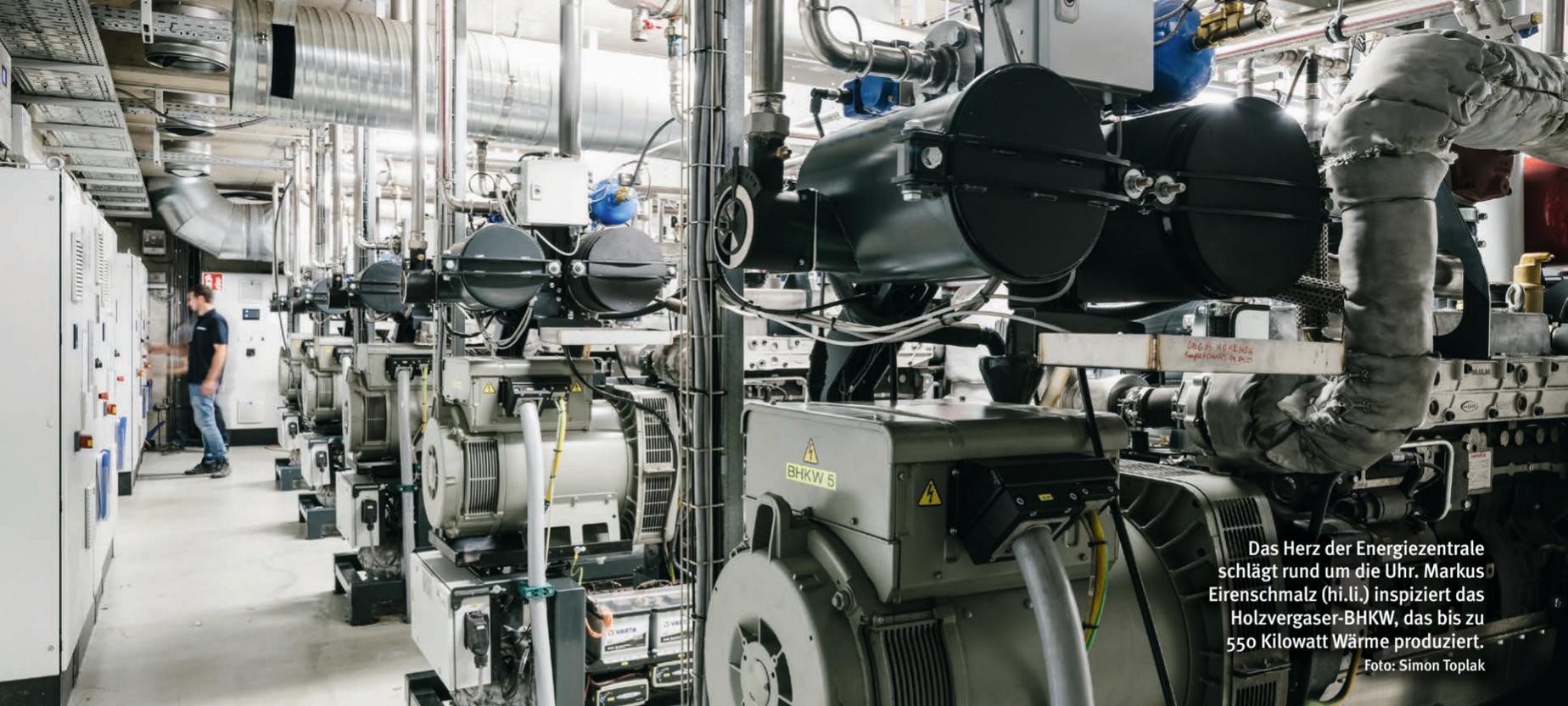
Das Herz der Energiezentrale schlägt rund um die Uhr. Markus Eirenschmalz (hi.li.) inspiziert das Holzvergaser-BHKW, das bis zu 550 Kilowatt Wärme produziert.
